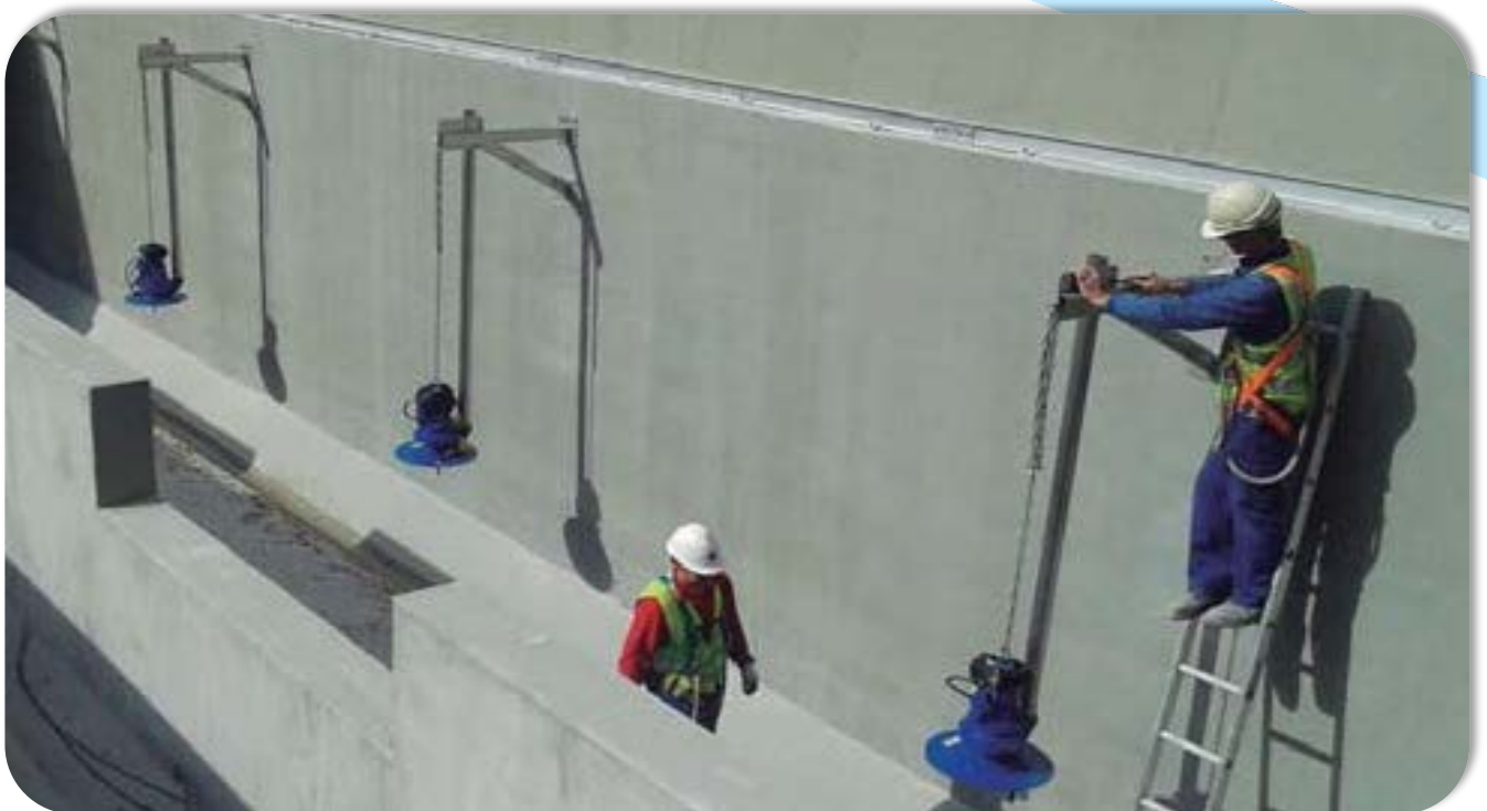
Instalación de equipos Aeroflo ® en canal de pretratamiento en EDAR urbana
